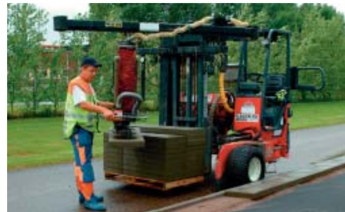
Läggningsskärar med vakuumsug.
