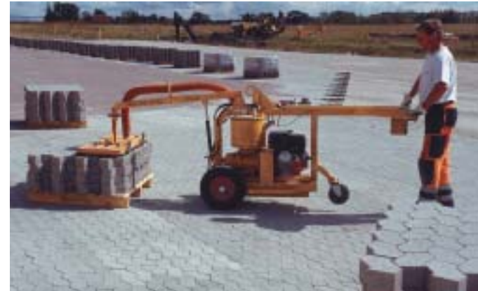
Läggningsskärar med vakuum.
