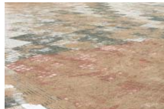
Efter avslutad vibrering eftersandas beläggningen rikligt.
