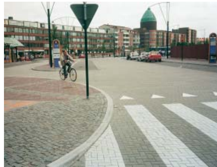
Nedsänkt kantstöd och ordentligt markerad passage för gångtrafikanter.
