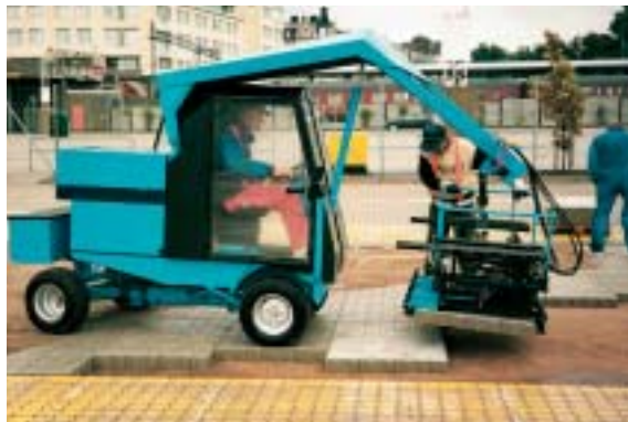
Maskinen arbetar med modulmått och lyfter och lägger en modul i taget. Fogning sker direkt efter läggning.
