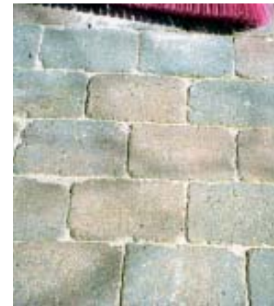
Välfyllda fogar håller ogräset borta.
