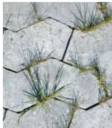
Ofyllda fogar skapar förutsättningar för ogräs.
